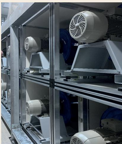
Drehzahlgeregeltes Mehrventilatorensystem. Foto: Howatherm
