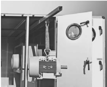
Auszugsvorrichtung zur Motorrevision
