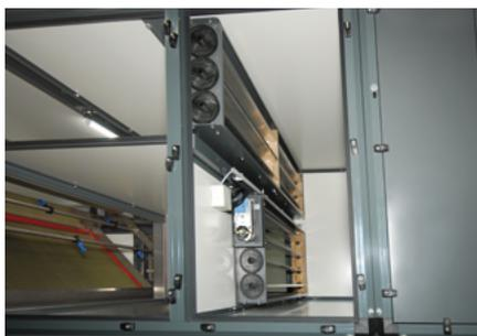
Umschalteinrichtung für direkte und indirekte Kühlung / Hybrid-Wärmeübertrager mit Befeuchtung
