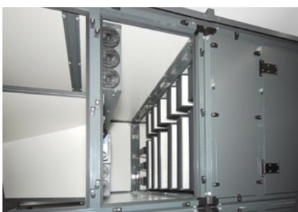
Umschalteinrichtung mit hochwertiger Feinfiltertechnik F7
