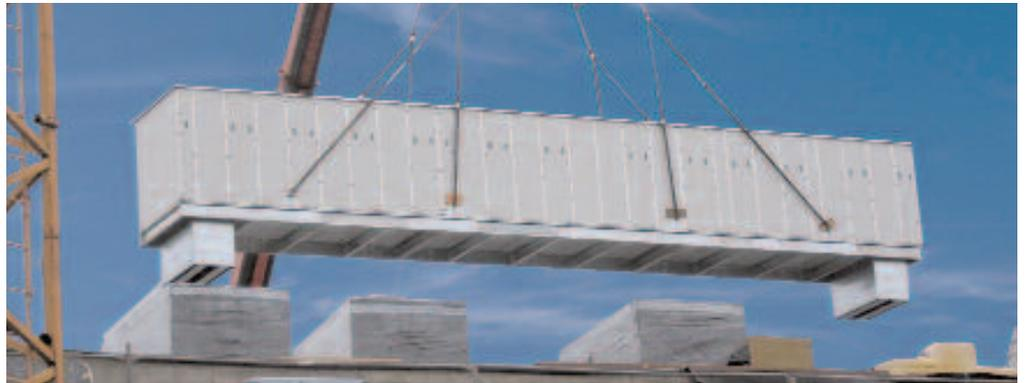
RLT-Gerät System TwinBox zur Verringerung der Schallemission für das Werk von Wagner-Pizza, 30.000 m<sup>3</sup>/h Luftleistung
