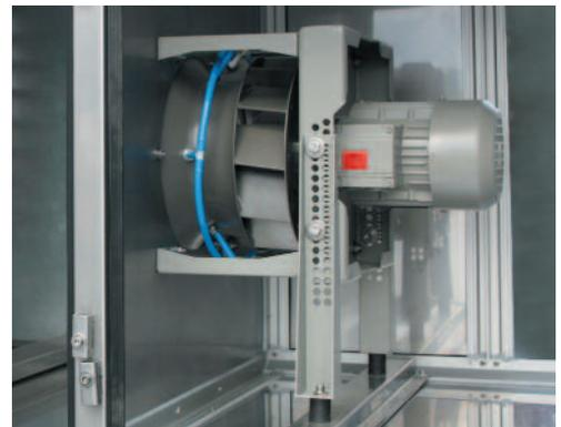
Ventilator mit freilaufendem Rad System ETA®
