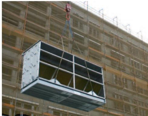
Demontierbare Kranösen, stabile Geräterahmen
