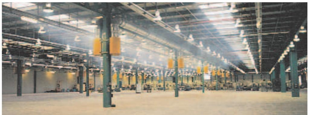
Lüftungsgeräte mit insgesamt 360.000 m<sup>3</sup>/h Luftleistung belüften die Produktionshallen beim Getriebehersteller ZF in Saarbrücken. Die Aufnahme zeigt einen Strömungsversuch.
