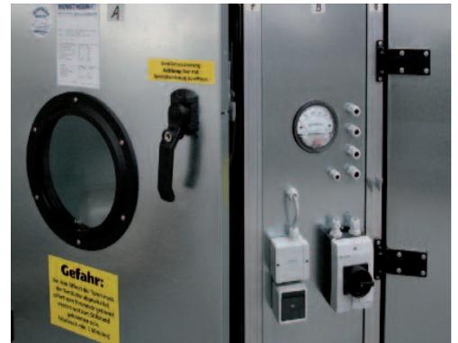
Gerätetür mit Sichtfenster und Hebelverschluss
