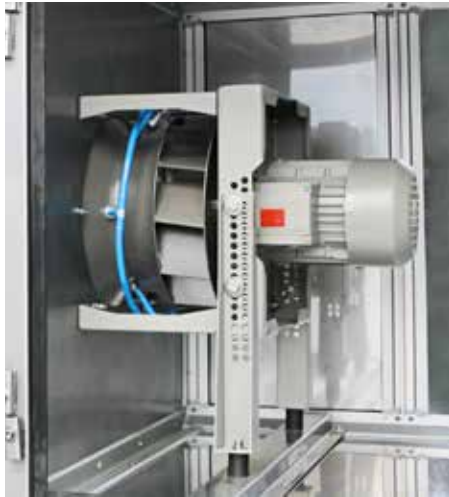
Bild 3: Direktgetriebener freilaufender Ventilator
