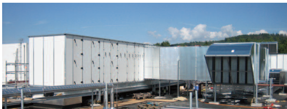
Einbau von Schalldämpfern in das Kanalsystem.
